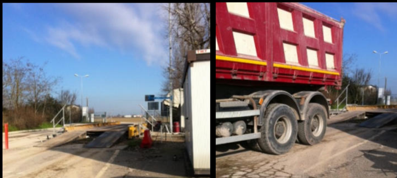
Pesatura delle macerie nell'impianto di prima destinazione del rifiuto – Discarica di Medolla
