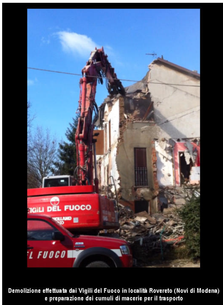
Attività di demolizione selettiva
