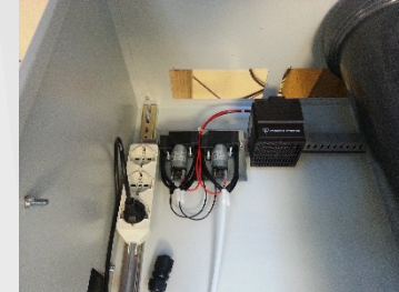
Cablaggio e montaggio unità di riscaldamento
