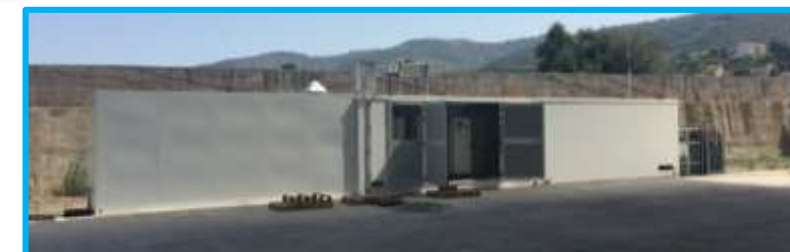
Container in cemento armato atti ad ospitare i componenti dell'impianto ad alta pressione
